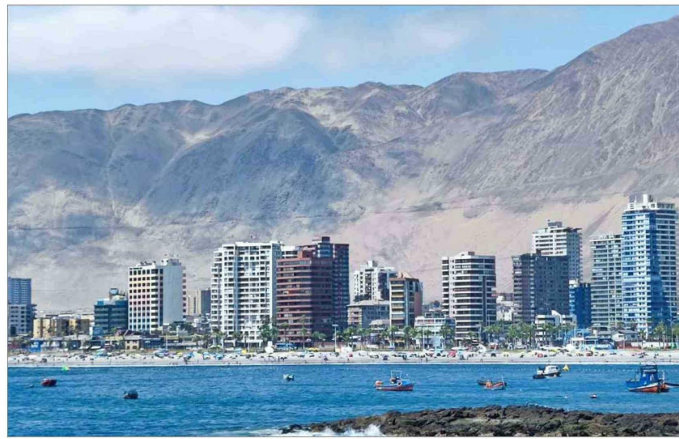
El plan regulador de Iquique, que data de 1981, da libertad de densidad para construcción.
