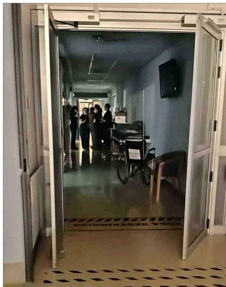
DIFICULTADES. — En algunos recintos médicos, como el Hospital Clínico de la UC, hubo problemas con los generadores de emergencia.
