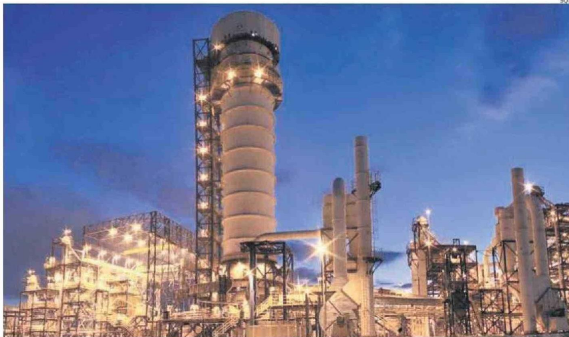
SQM INDUSTRIAL INGRESÓ EL PROYECTO MODIFICACIÓN DE LAS INSTALACIONES PRODUCTIVAS Y TRANSPORTE DE NITRATOS FAENA MINERA COYA SUR.
