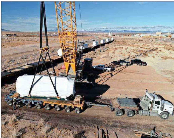
Un electrolizador se encuentra en la plataforma de un camión en el proyecto de Almacenamiento Avanzado de Energía Limpia que se está construyendo en Delta, Utah.
