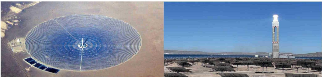
Planta Crescent Dunes, ubicada al noroeste de Las Vegas (EE.UU.). Fuente: Wikipedia. Planta Cerro Dominador, ubicado en la Región de Antofagasta. Fuente: Cerro Dominador.
