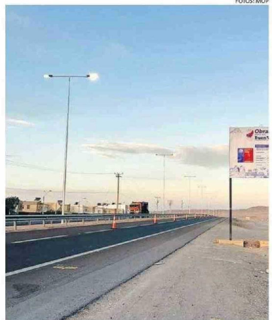
PROYECTO CUMPLE CON LA NUEVA NORMATIVA PARA PREVENIR LA “CONTAMINACIÓN LUMÍNICA”.
