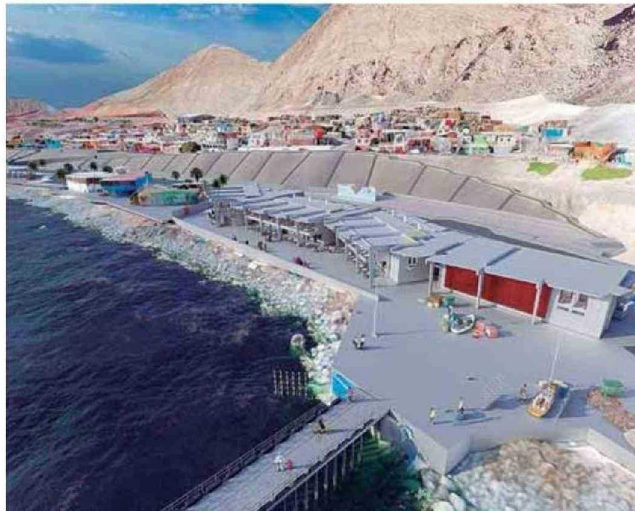
LAS OBRAS SE DESARROLLARÁN EN UN TERRENO DE CUATRO MIL METROS CUADRADOS.
