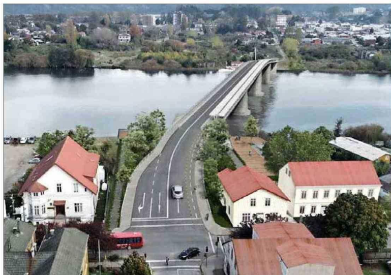
TAMAÑO. — El Cochrane tendrá 325 mts de largo; 13,5 mts de alto; 17,3 mts de ancho y cuatro cepas, tres de las cuales estarán en el lecho del río.
