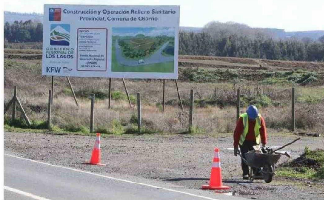
EL FRACASADO PROYECTO DEL RELLENO SANITARIO COMENZÓ SUS OBRAS EN 2014 Y QUEDÓ PARALIZADO EN 2015.
