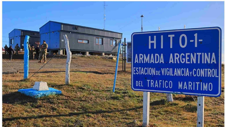
La construcción argentina en el Hito 1 en Magallanes.
