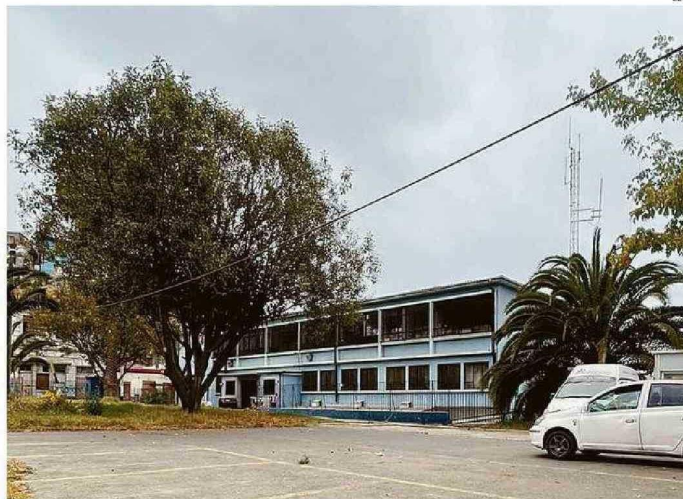
EXEDIFICIO DE LA PDI, HOY ES UNA BODEGA
