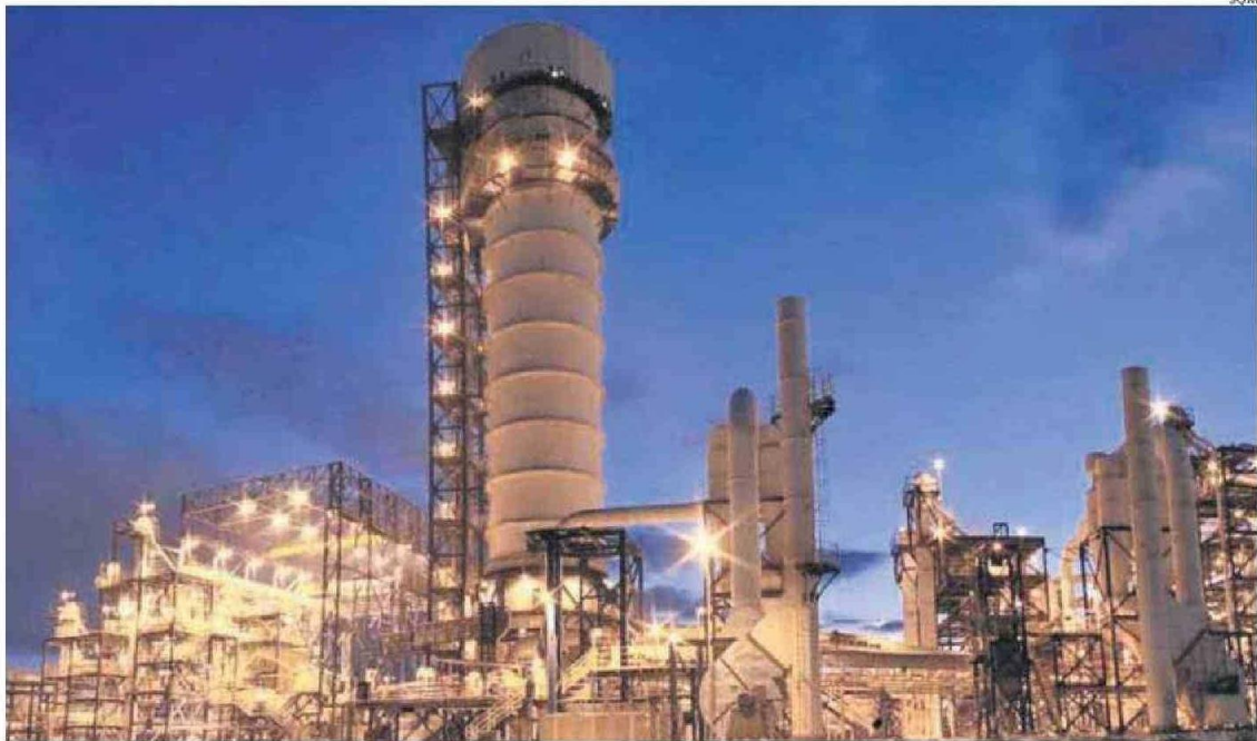
SQM INDUSTRIAL INGRESÓ EL PROYECTO MODIFICACIÓN DE LAS INSTALACIONES PRODUCTIVAS Y TRANSPORTE DE NITRATOS FAENA MINERA COYA SUR.
