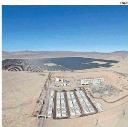
BESS TAMAYA COMENZÓ SU CONSTRUCCIÓN EN AGOSTO DE 2023.
