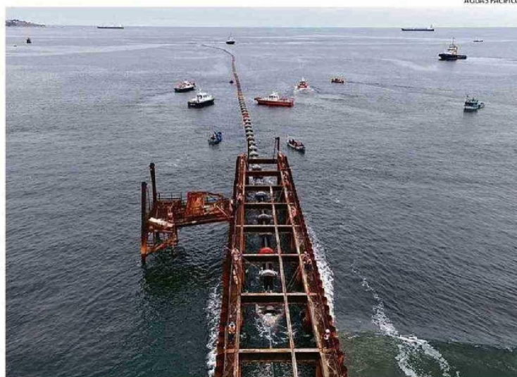
LA EMPRESA REALIZÓ LANZAMIENTO Y HUNDIMIENTO DE LA TUBERÍA DEL EMISARIO EN LA PLANTA.
