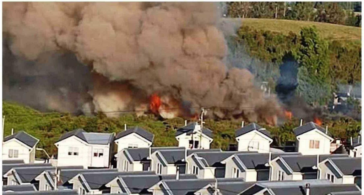
LAS LLAMAS ESTUVIERON A CERCA DE 10 METROS DE LAS VIVIENDAS DE LA VILLA MIRADOR 5, EN EL SECTOR ALTO DE CASTRO.
