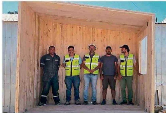
El proyecto "Panel CLT-R" desarrolla viviendas industrializadas con paneles de madera contra laminada reforzada.
