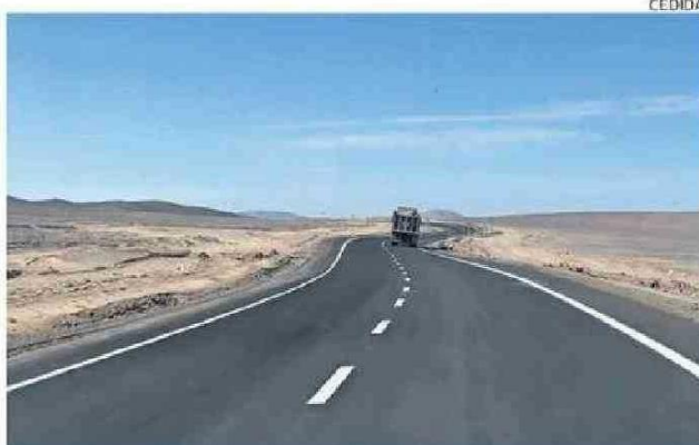
EL TRAMO SUMA 20 NUEVOS KILÓMETROS DE PAVIMENTO.
