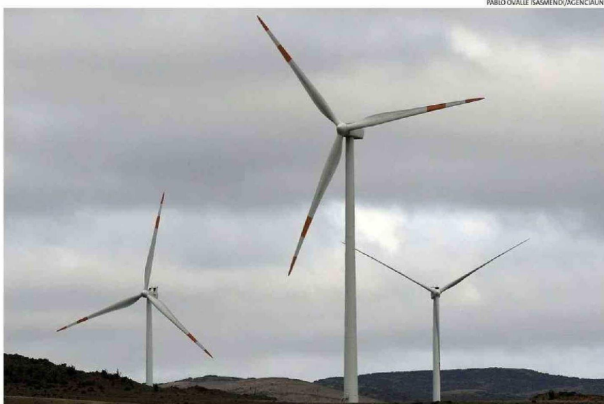
LOS PARQUES EÓLICOS SE HAN MULTIPLICADO EN CHILE EN LAS ÚLTIMAS DÉCADAS.
