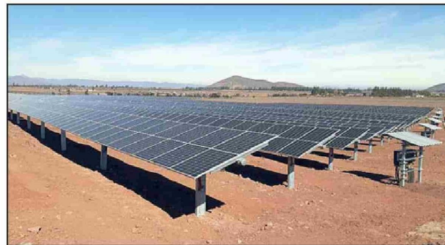
Similar a esto es lo que se pretende instalar en Catemu. (Imagen referencial)
