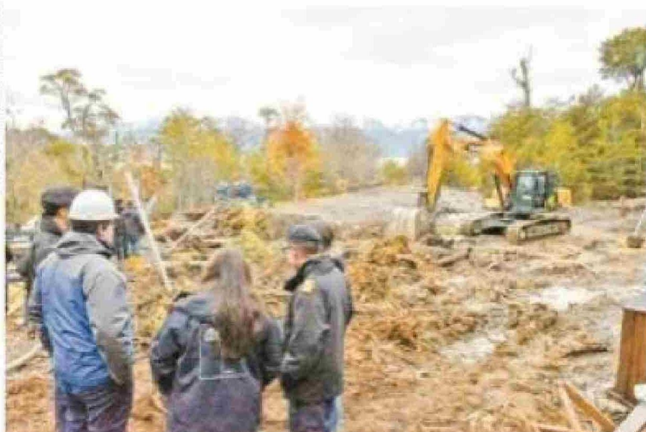
Las autoridades y representantes de Aguas Magallanes observan el desarrollo de las faenas con miras a habilitar la zona de captación de agua potable.
