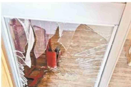
El vidrio destruido y la ventana por donde se supone ingresaron los desconocidos.
