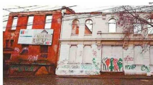
LA UV TRABAJÓ PARA RESTAURAR SINIESTRADO INMUEBLE.
