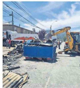
También se trabajó en la limpieza y remoción de escombros con maquinaria municipal.
