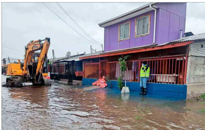
PROBLEMAS. — Las intensas lluvias caídas en Curicó, 80 mm en las últimas 36 horas, generaron serios problemas en la villa Don Matías.
