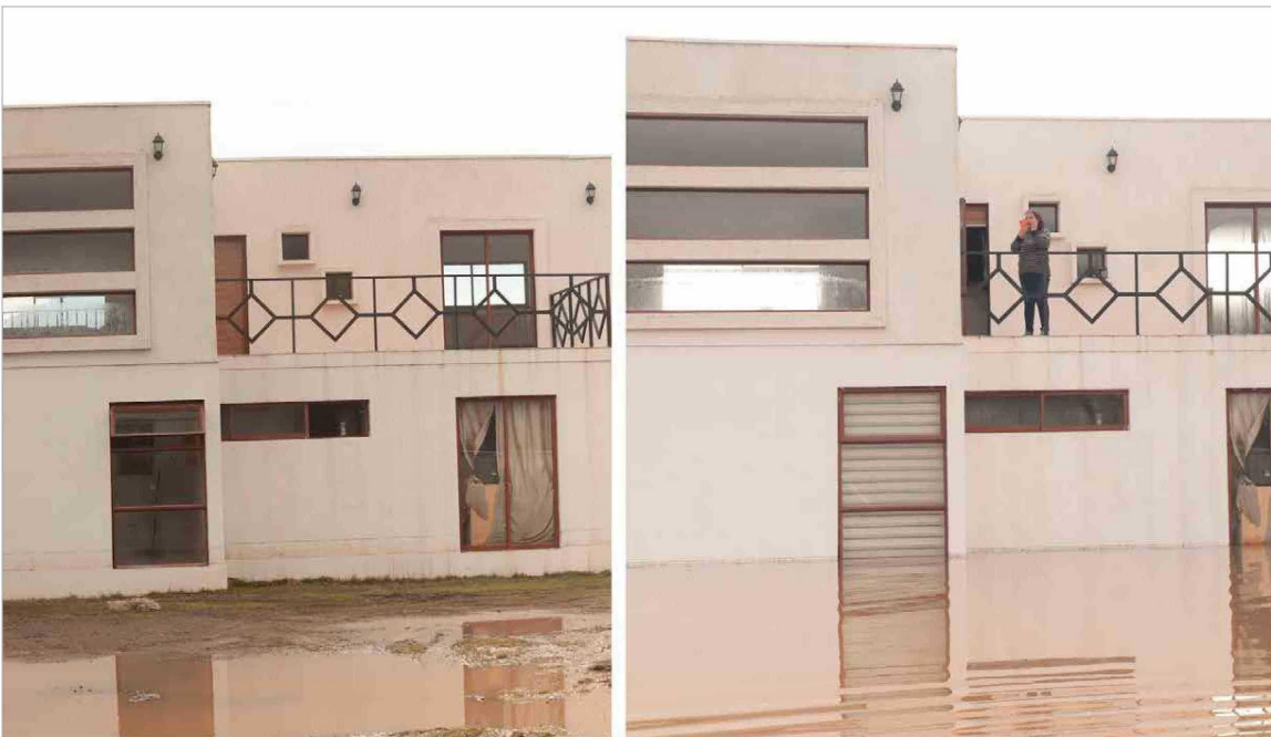
Una muestra de la crecida del agua que afectó la mayoría de las casas en las 32 parcelas del sector Santa Elena.
