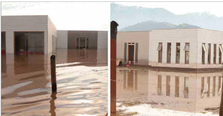
Una de las viviendas seriamente afectadas por las aguas desbordadas del estero "La Cadena", se aprecia el antes y después.
