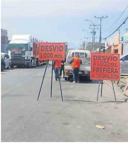
TRABAJOS SON REALIZADOS POR AGUAS DEL ALTIPLANO.
