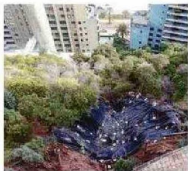
Socavones. Pág. 7 Piden informes a Concón, Viña, Serviu y DOH
