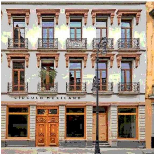
A partir del reciclaje de un edificio de 1907 surge el hotel boutique Círculo Mexicano.
