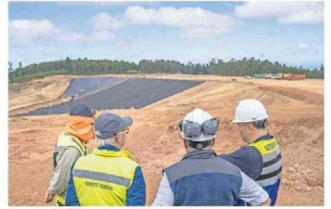
Durante el 2024 realizaron 59 inspecciones.
