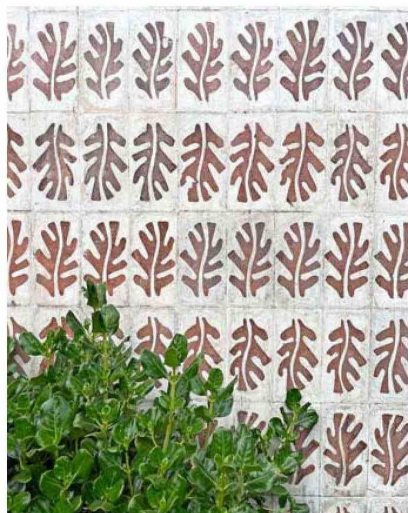
Muros de la Remodelación Paicaví (Grupo TAU, 1966), acá usaron un formato rectangular con motivos orgánicos.
