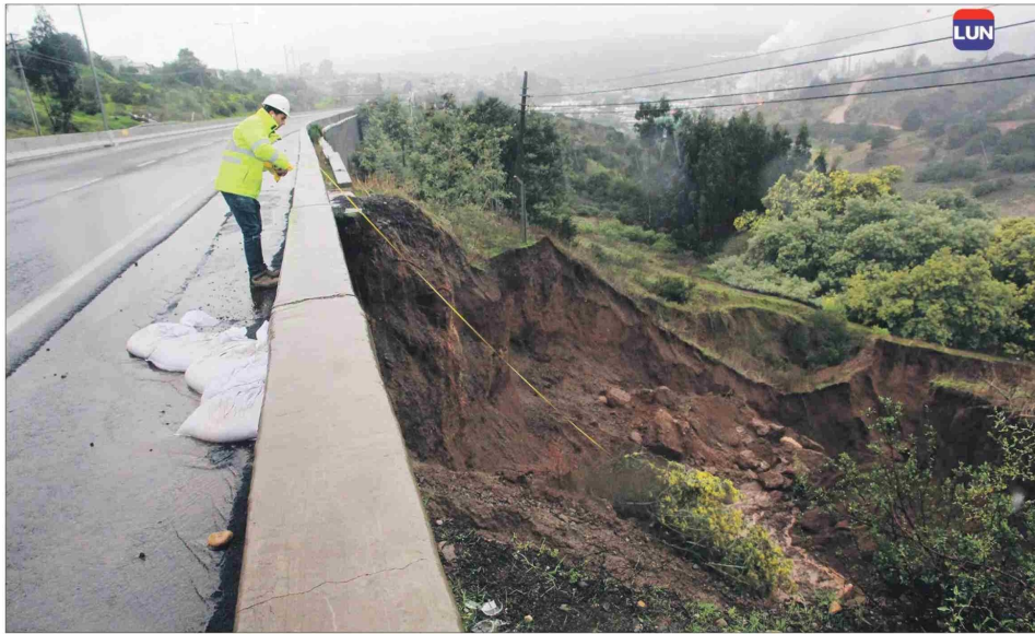
Para enfrentar la emergencia, el MOP desvió las aguas del colector lejos del socavón.
