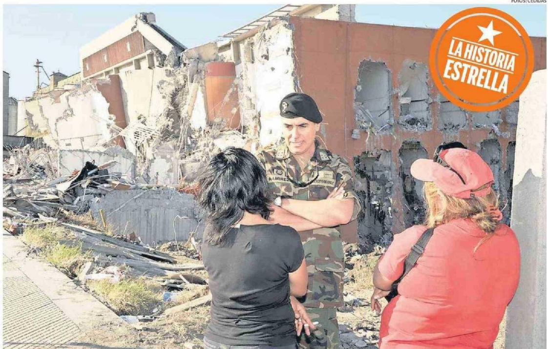
GENERAL (R) GUILLERMO RAMÍREZ CHOVAR DIALOGA CON DOS CIUDADANAS FRENTE A LAS RUINAS DEL EDIFICIO “ALTO RÍO” DE CONCEPCIÓN, DERRUMBADO A LAS 3.34 HORAS.
