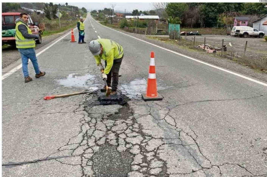
RUTA BULNES QUILLÓN ESTÁ EN MAL ESTADO, LO QUE HA GENERADO MOLESTIA DE AUTOMOVILISTAS Y EL ALCALDE MIGUEL PEÑA.
