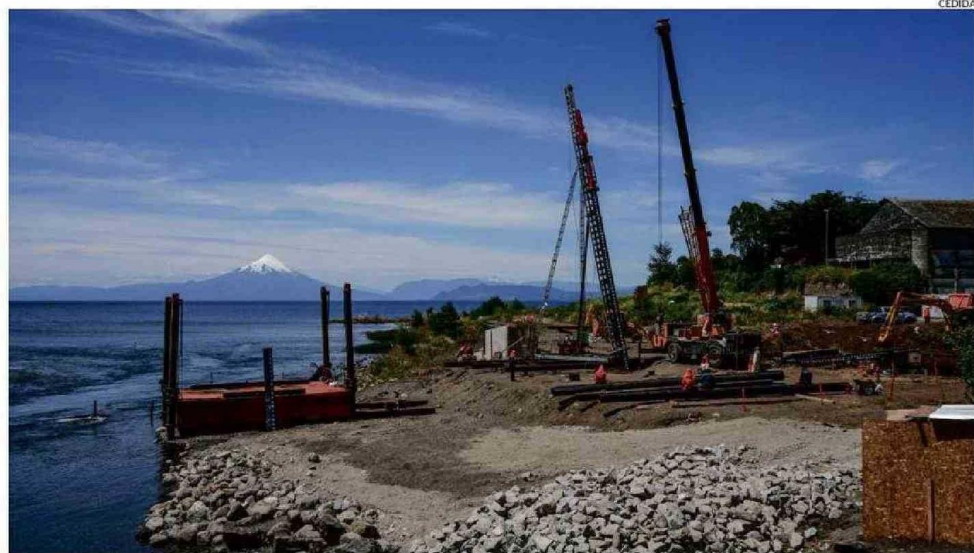
LAS OBRAS ESTÁN AVANZANDO EN EL TRAMO 1, QUE INCLUYE UNA PASARELA PEATONAL QUE CRUZARÁ EL RÍO MAULLÍN.
