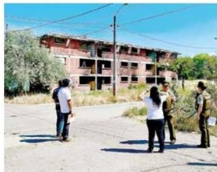
"Estamos a las puertas de poder iniciar las obras de demolición", indicó la directora de Serviu Maule, Paula Oliva.
