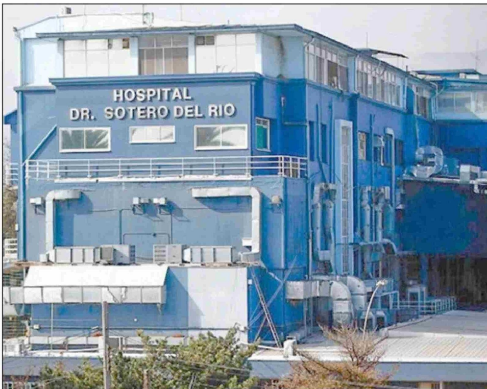
Hospital Sótero del Río en Puente Alto.
