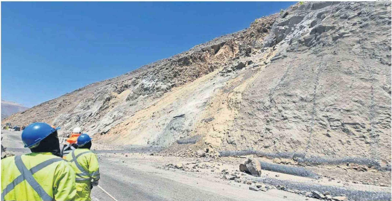
EN EL SECTOR DE LOS DERRUMBES E INSTALAN MALLAS METÁLICAS EN LA LADERA DEL CERRO, A MODO DE EVITAR EL DESPRENDIMIENTO DE MATERIAL Y DAR SEGURIDAD A QUIENES TRANSITAN
