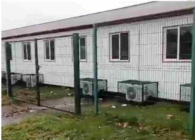
LA ESCUELA FUNCIONA CON MÓDULOS DE EMERGENCIA DEBIDO A LA REPARACIÓN DE LA ESTRUCTURA.
