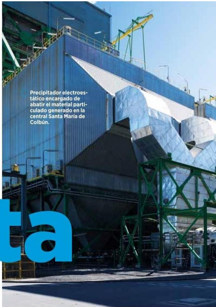
Precipitador electrostático encargado de abatir el material particulado generado en la central Santa María de Colbún.
