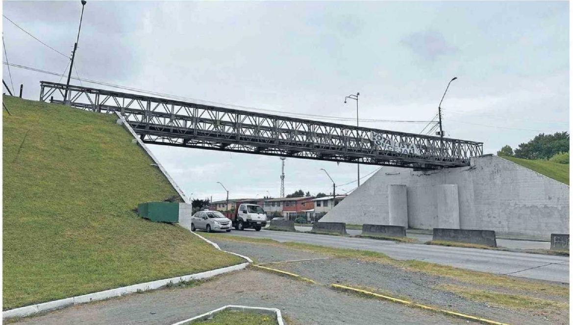
El Puente Perales conecta la Avenida Colón con la Autopista Concepción – Talcahuano, que es la principal vía de acceso hacia la comuna puerto.
