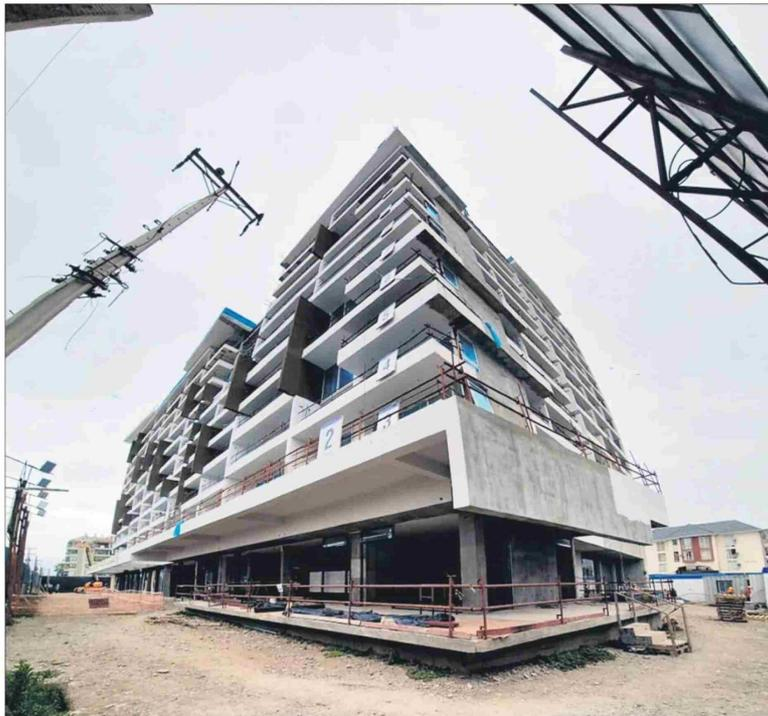
El primer piso, destinado a comercio y servicios, tiene en su mayoría estructuras de tabique y vidrio para que colapsen fácilmente en caso de que llegue el agua. Los muros estructurales están perpendiculares a la línea de la costa.
