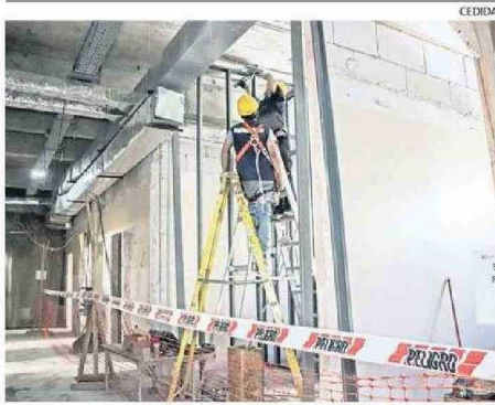
CONSTRUCCIÓN DE PABELLONES EN EL HOSPITAL HIGUERAS.
