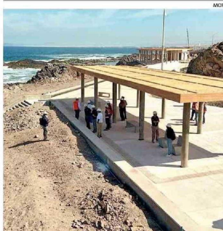
TROCADERO-LOS PINARES ES UNA DE LAS OBRAS EN DESARROLLO.
