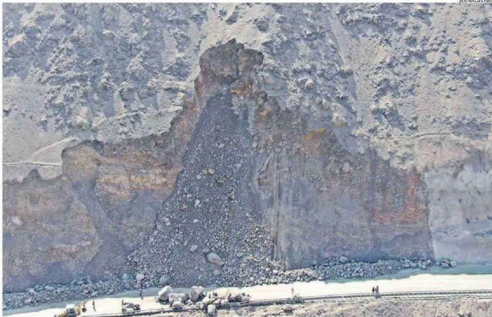
VISTA AÉREA DE CÓMO QUEDÓ EL SITIO AFECTADO POR LOS DERRUMBES DE LA SEMANA PASADA.
