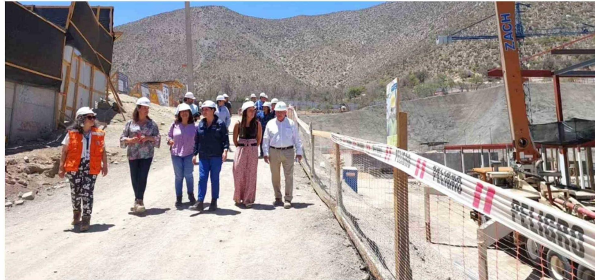
Durante este martes, consejeros regionales llegaron al lugar para ver el avance de las obras del nuevo recinto de salud.
