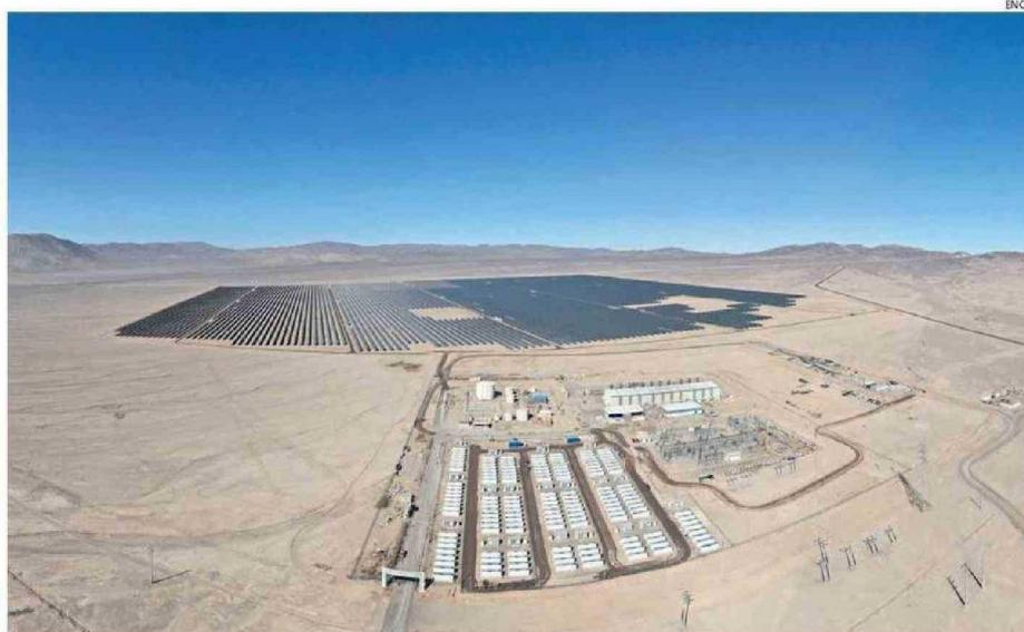
PROYECTO CUENTA CON 152 CONTENEDORES DE BATERÍAS CARGADOS CON ENERGÍA GENERADA POR LA PLANTA SOLAR TAMAYA.
