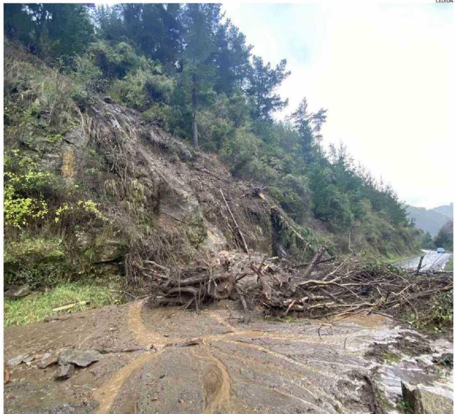
LA RUTA U-220 KILÓMETRO 45, EN EL SECTOR DE COFALMO, EN SAN PABLO, SE VIO INTERRUMPIDA POR EL DERRUMBE DE PARTE DEL CERRO.
