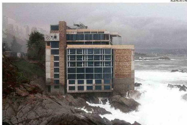
HAY ORDEN DE DEMOLICIÓN CONTRA EL HOTEL DICTADA POR SEREMI DE VIVIENDA DE VALPARAÍSO.
