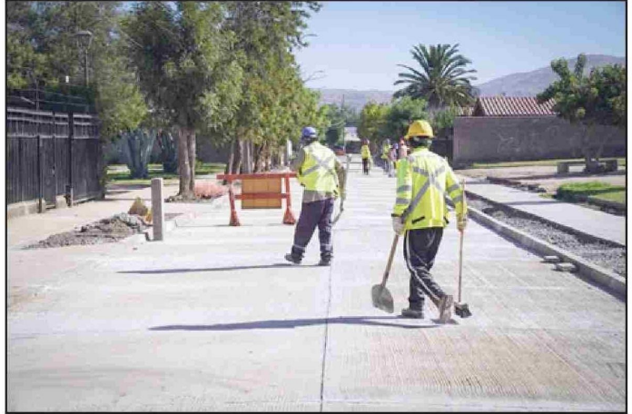
Avanzan los trabajos de pavimentos participativos en San Felipe.
