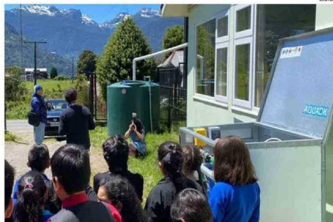
EN ALGUNAS ESCUELA DE LA REGIÓN YA SE INSTALARON EQUIPOS PARA PURIFICAR LAS AGUAS LLUVIAS.
